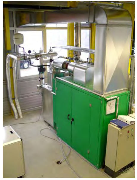
Mikrogasturbine auf Erdgasbetrieb Elektrische Leistung 28 kW Thermische Leistung 60 kW
