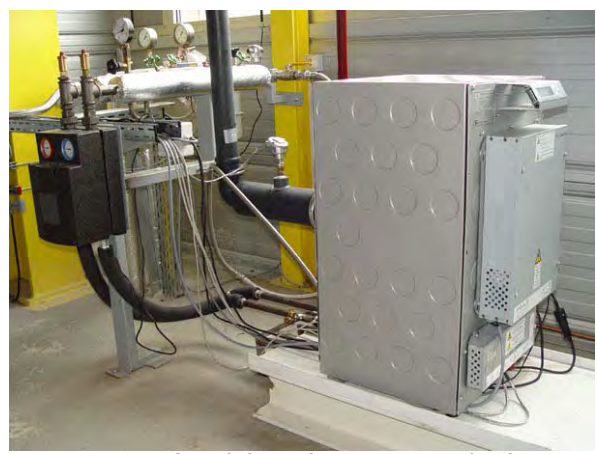
Stirling Whispergen Elektrische Leistung 1,2 kW Thermische Leistung 8 kW
